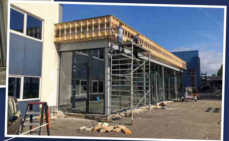
Luifel aanbrengen boven showroom
