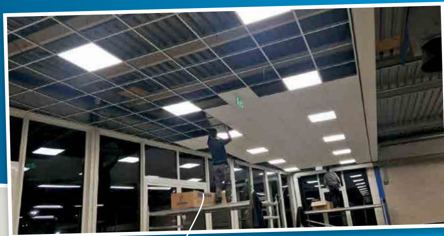
Plafond aanbrengen
