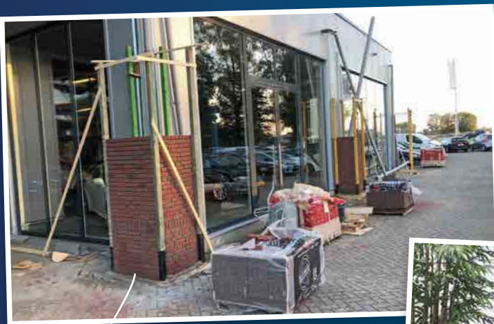
Zuilen entree metselen
