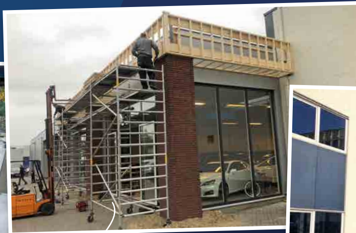
Luifel aanbrengen boven showroom
