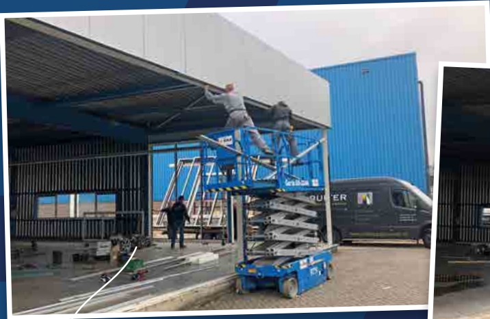
Afwerking beplating
