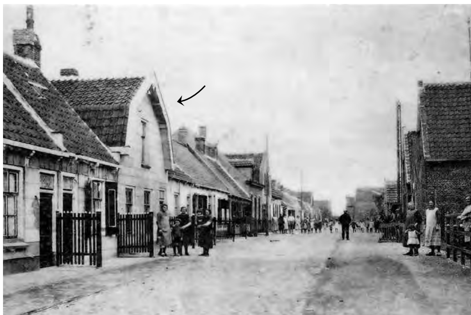
De Achterweg met links het consistoriehuis (zie pijl) gezien vanaf de kerk. De achterkamer ervan werd gebruikt voor vergaderingen en catechisaties.
